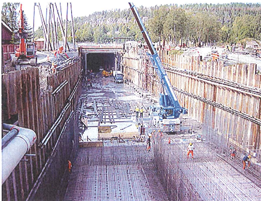
Figur 4: Bygging av Jernbanetunnel mellom Sandvika og Asker ved Bjørnegård i Bærum. Byggegropa for tunnelen sommeren 2003 (Foto: Tim Mitchley / for Jernbaneverket). Grunnforholdene var vanskelige, med svært bløte masser. Det var derfor nødvendig med ulike sikringstiltak og trinnvis utgraving av massene. På det meste var byggegropa 15 meter dyp.
